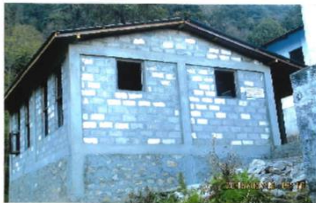
再建工事完成
